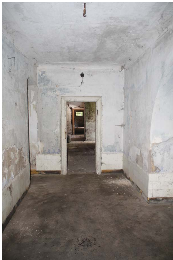
33. Přízemí, místnost 1.04, průhled od západu
