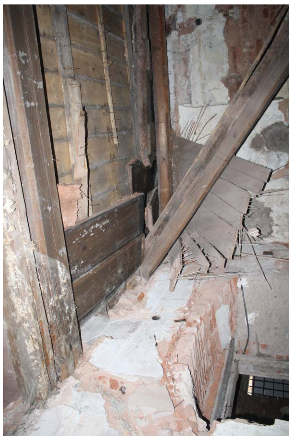
48. Přízemí, místnost 1.08, torzo barokního trámového stropu
