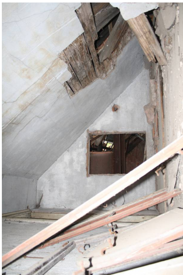
104. Podkroví, východní část, průhled předsíní při podkrovní místnosti od západu
