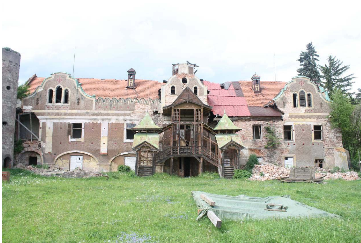
02. Celkový pohled na jižní průčelí zámku s dominantní konstrukcí dřevěného vnějšího schodiště
