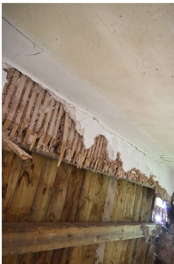
89. Patro, místnost 2.11, detail torza stropní konstrukce
