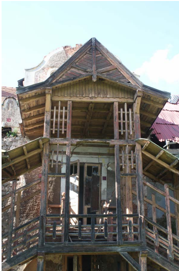
10. Jižní průčelí, detail dřevěného schodiště
