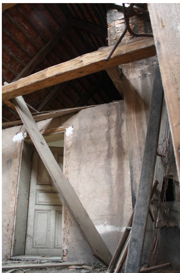
103. Podkroví, východní část, pohled na podkrovní místnost
