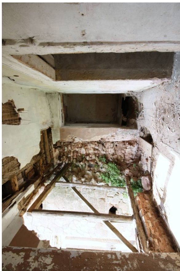
73. Patro, místnost 2.06, průhled od východu
