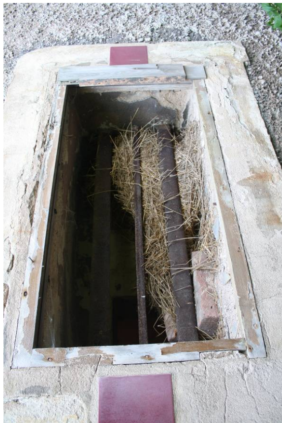
20. Severní průčelí, detail západního okna v přízemí
