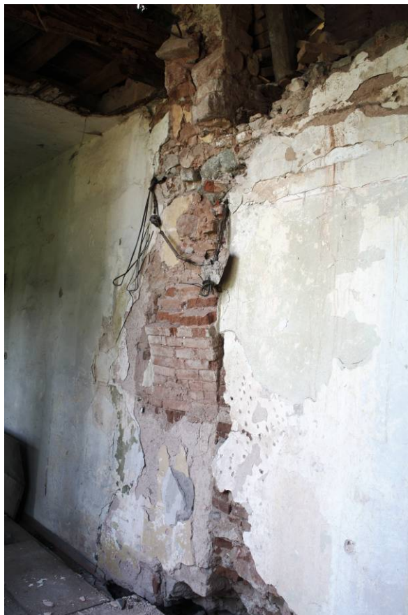
62. Patro, místnost 2.01, S stěna v místě JV nároží původní raně barokní stavby
