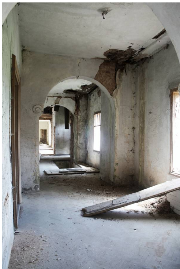
72. Patro, průhled z místnosti 2.05 k východu
