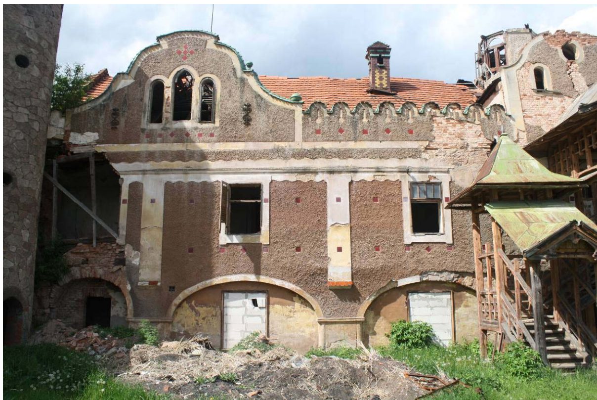
03. Jižní průčelí, západní část
