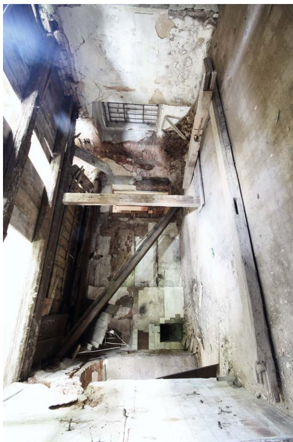
46. Přízemí, místnost 1.08, průhled od východu
