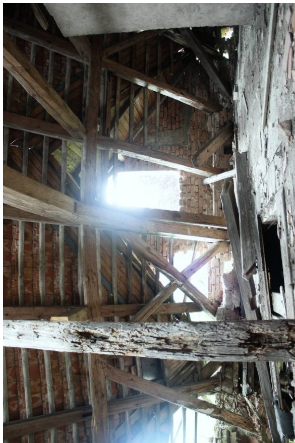
101. Podkroví, východní část, pohled od jihu na krov
