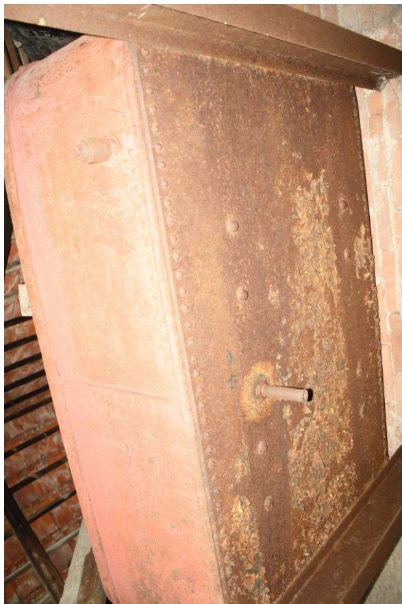
107. Podkroví, východní část, detail plechové nýtované nádrže na vodu
