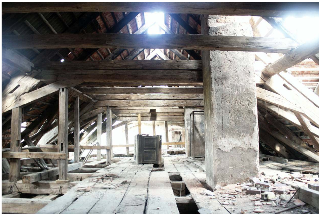
92. Podkroví, západní část, průhled od západu
