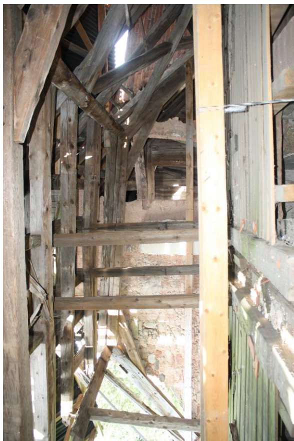
94. Podkroví, západní část, pohled na krov při protipožárním štítu
