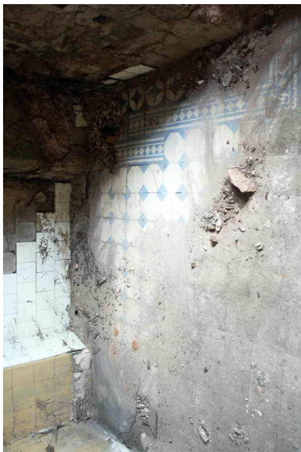
68. Patro, místnost 2.03, detail dlažby
