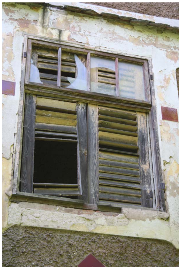
14. Východní průčelí, detail prostředního okna v patře
