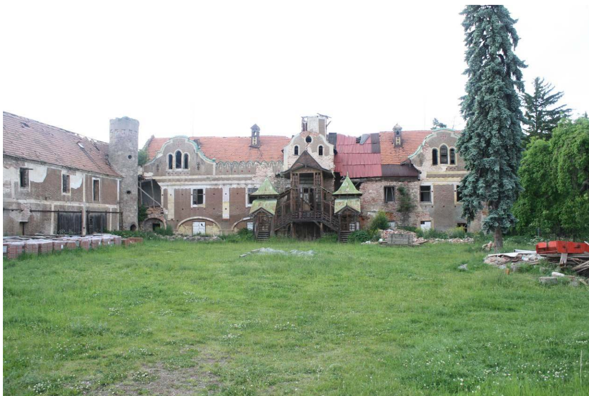
01. Celkový pohled na zámek od jihu. Vlevo na snímku zachycena část navazujícího hospodářského křídla a romantická válcová věž
