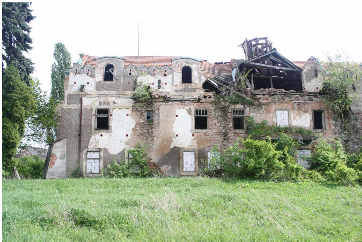
17. Severní průčelí, východní část
