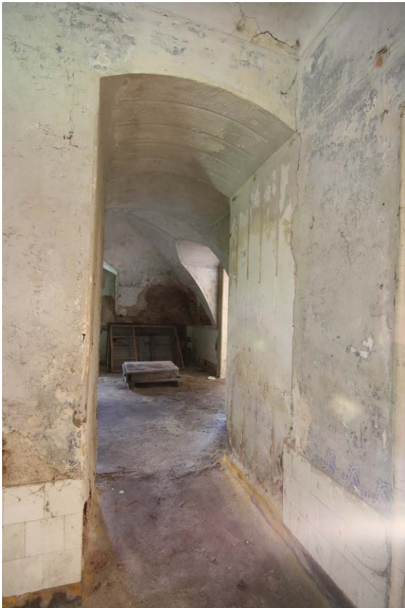
36. Přízemí, místnost 1.04, detail vstupu do 1.05
