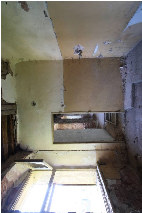
67. Patro, místnost 2.03, průhled od východu
