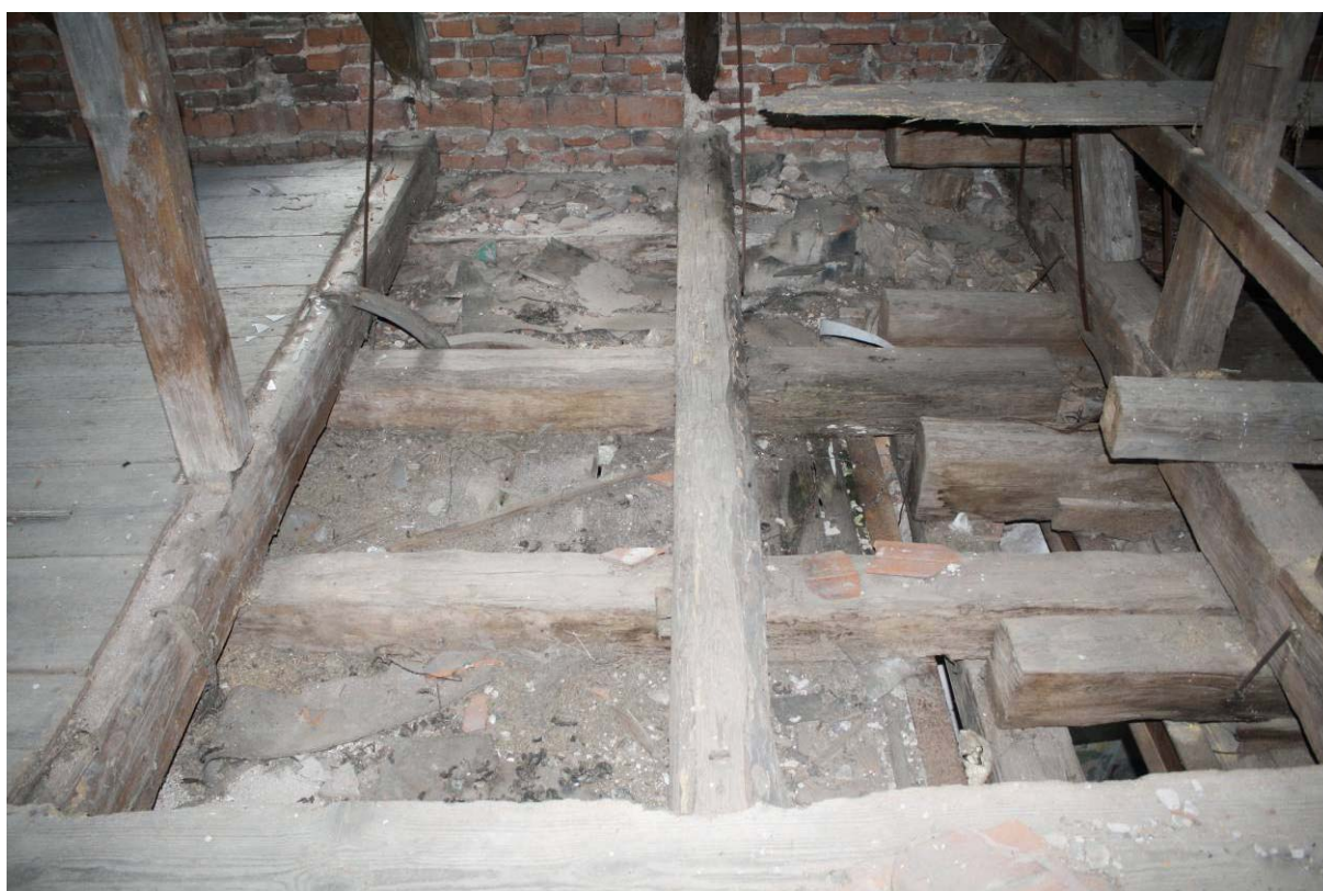
99. Podkroví, západní část, detail vyvěšení stropů u místností 2.07 a 2.08 v patře k vazným trámům krovu
