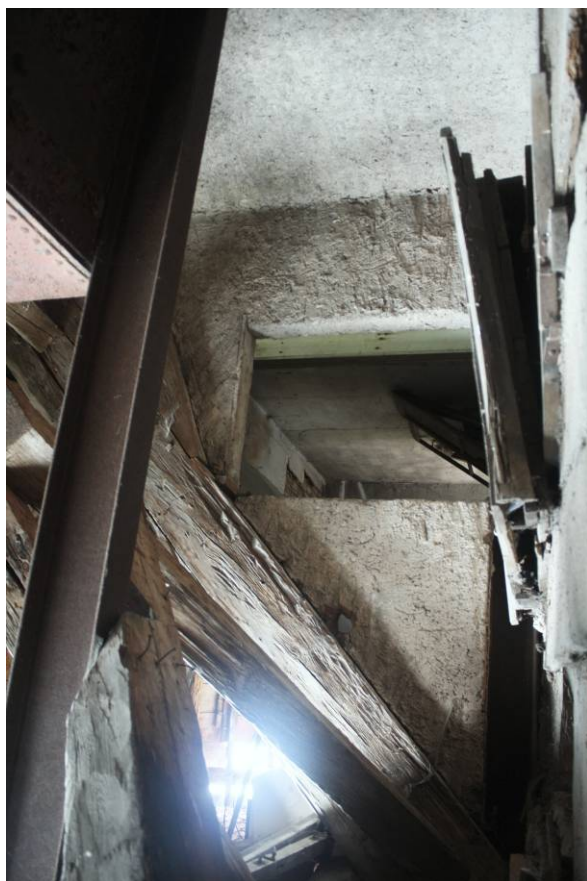
105. Podkroví, východní část, pohled na předsíní od východního štítu
