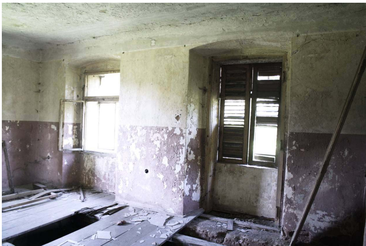
91. Patro, místnost 2.12, pohled na východní stěnu
