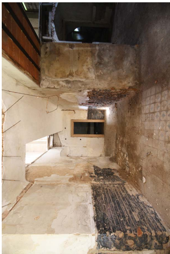
25. Přizemí, místnost 1.01, pohled od východu
