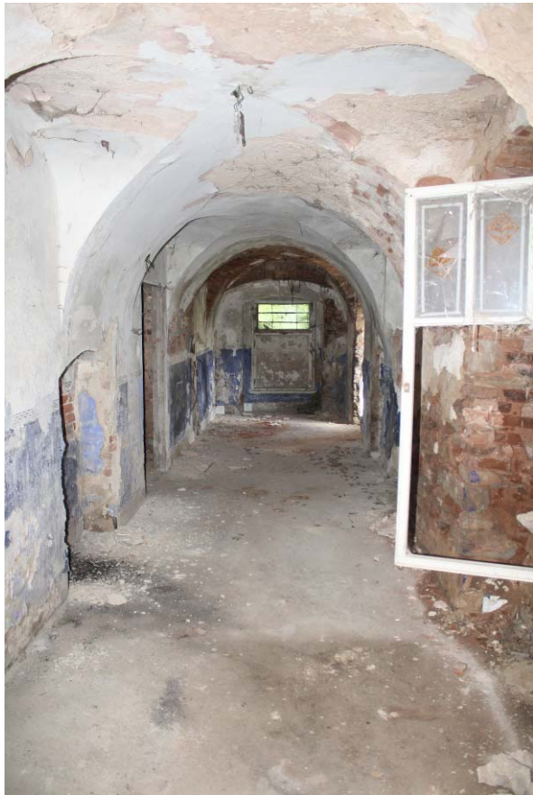
31. Přízemí, místnost 1.03, průhled od západu
