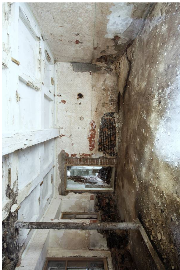
41. Přízemí, místnost 1.07, průhled od západu
