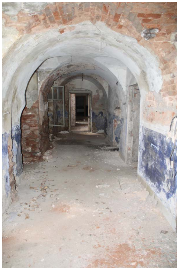
30. Přízemí, místnost 1.03, průhled od východu
