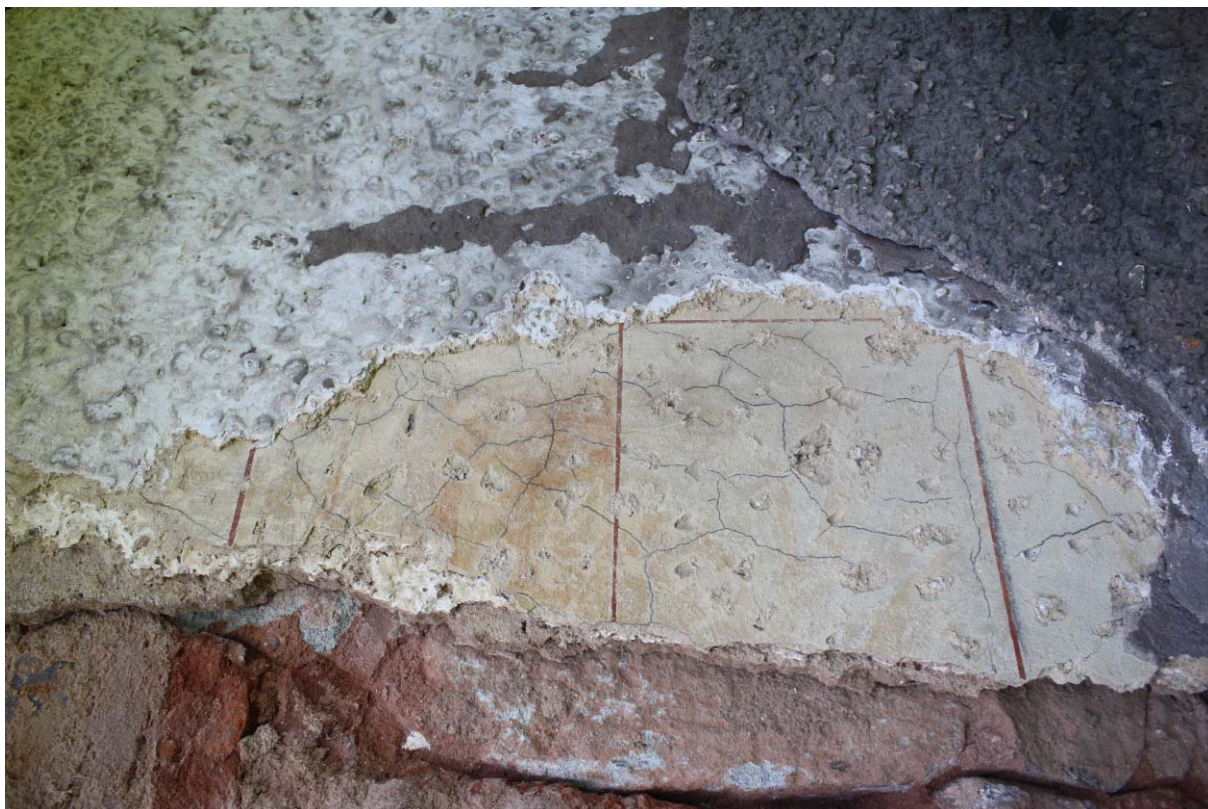
23. Severní průčelí, detail souvrství omítek (přízemí, partie pod balkónem)
