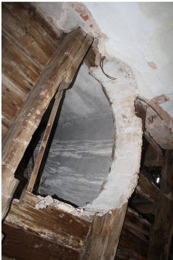
64. Patro, místnost 2.01 – V část, otvor po schodišti do podkrovní
