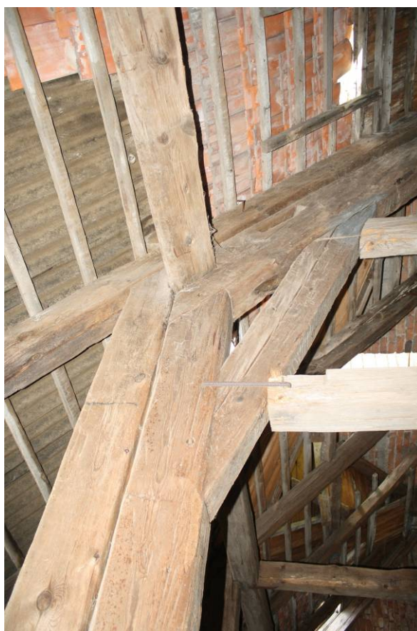
97. Podkroví, západní část, detail z plné příčné vazby krovu
