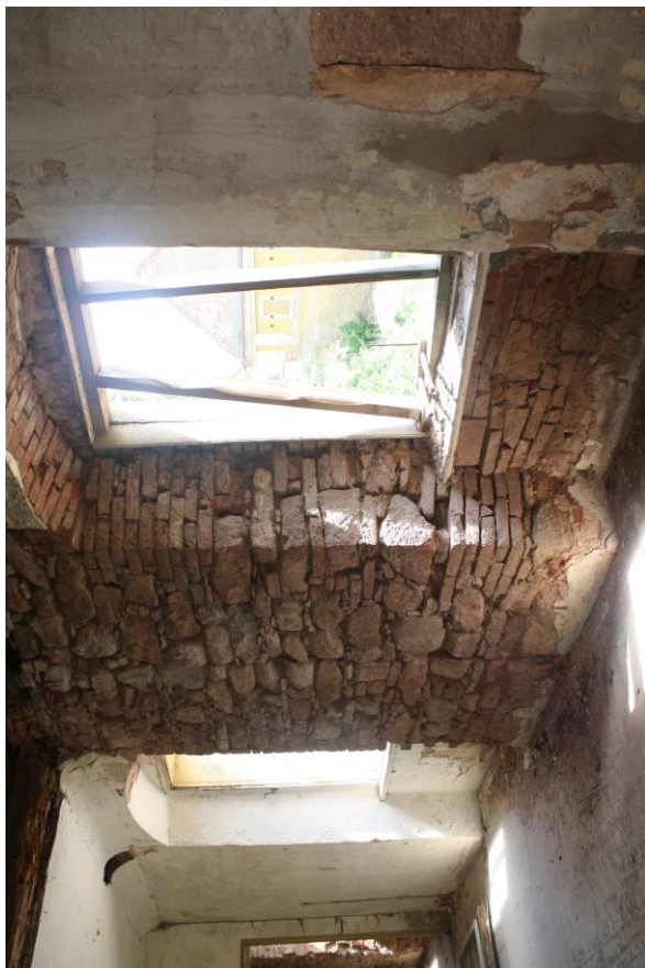
61. Patro, místnost 2.01, V část J stěny s patrnými spárami v místě původních pilířů
