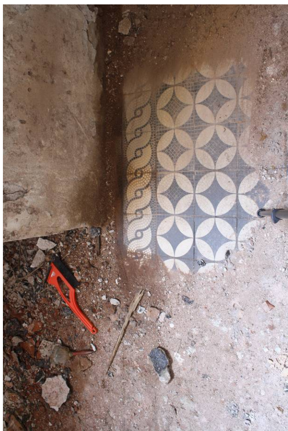
27. Přizemí, místnost 1.01, detail dlažby
