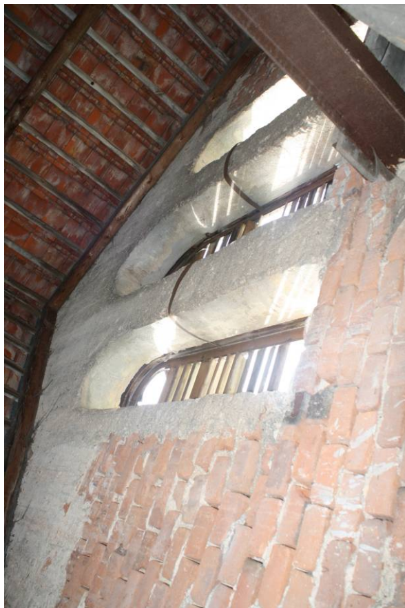
106. Podkroví, východní část, detail rubu východního štítu jižního průčelí
