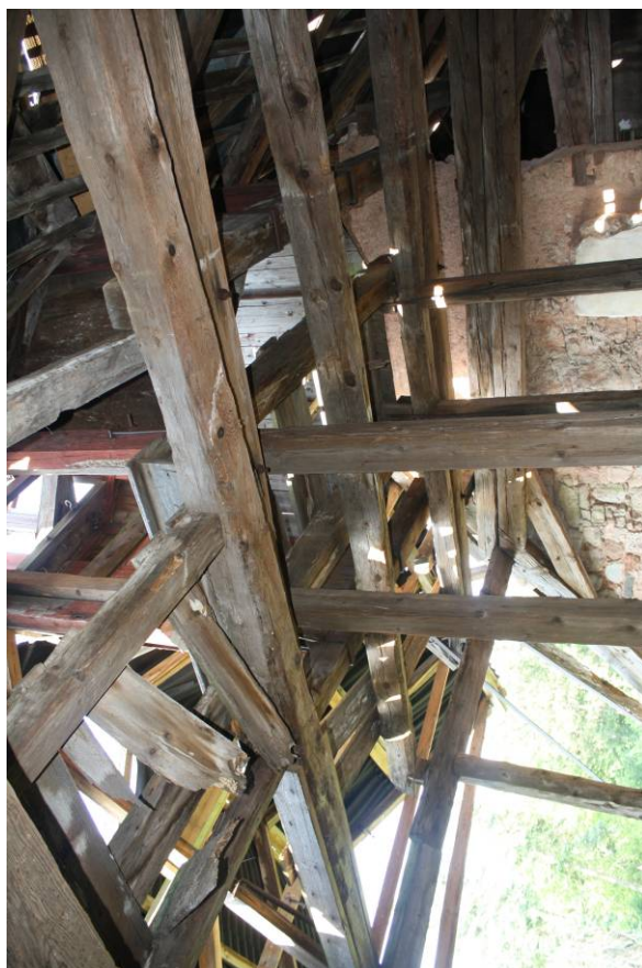
95. Podkroví, detail založení konstrukce věžičky
