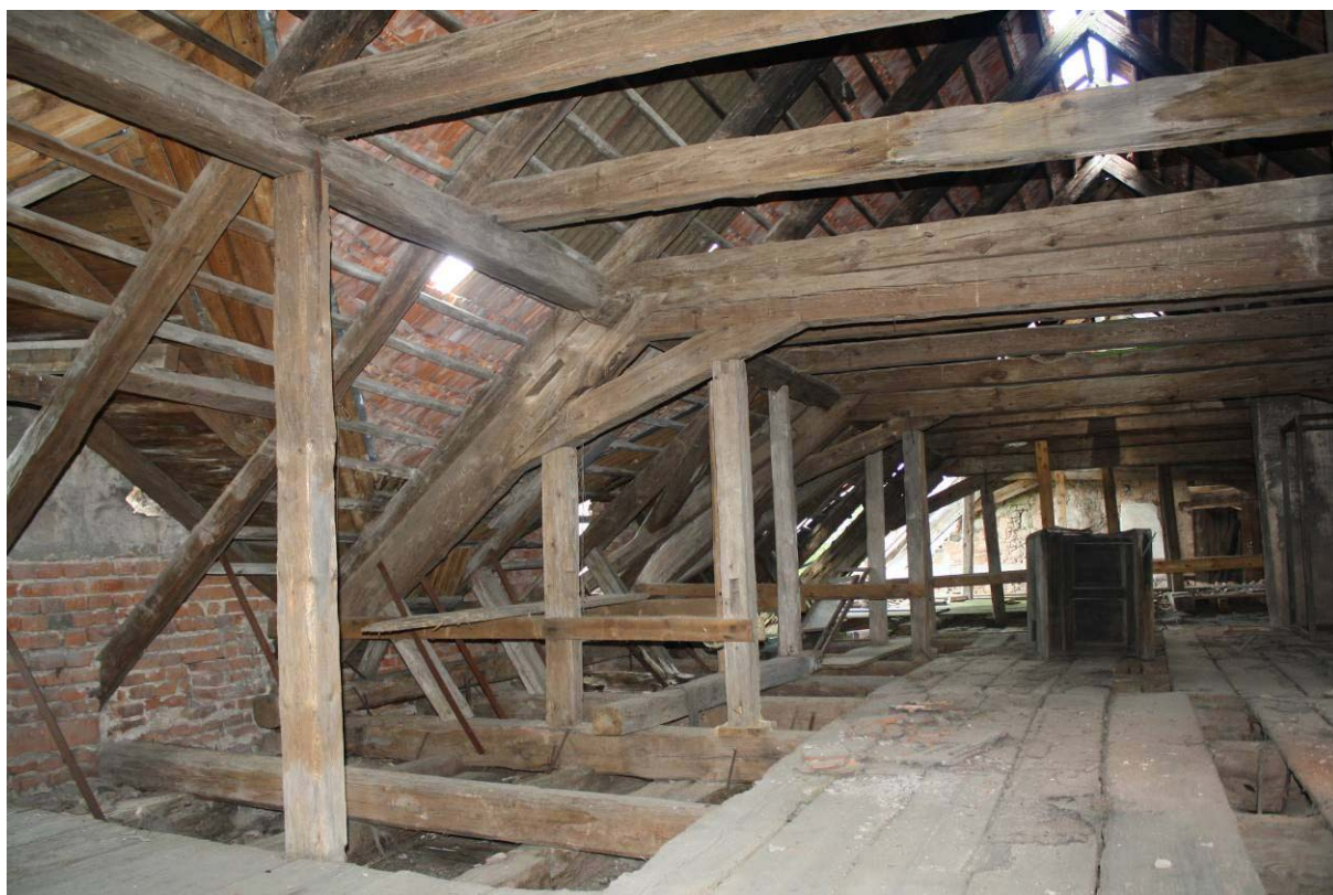
93. Podkroví, západní část, pohled na konstrukci krovu od západu
