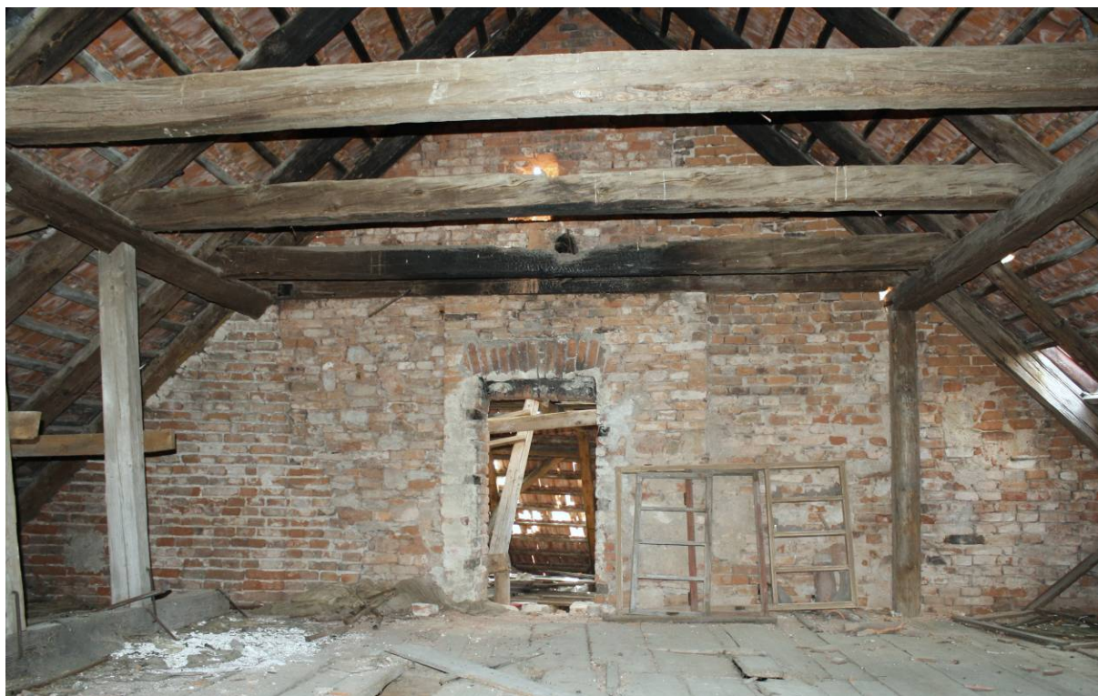
98. Podkroví, západní část, pohled k západnímu štítu
