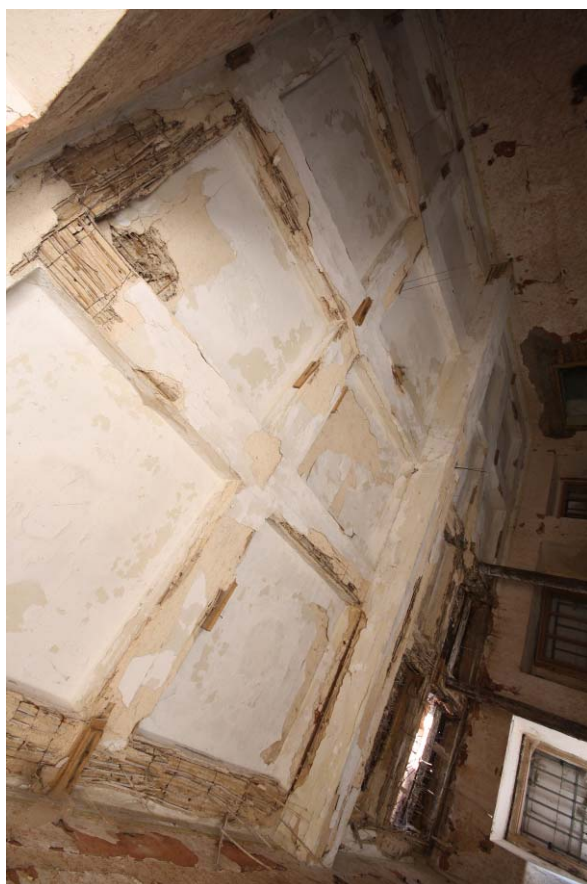
44. Přízemí, místnost 1.07, detail kazetového stropu
