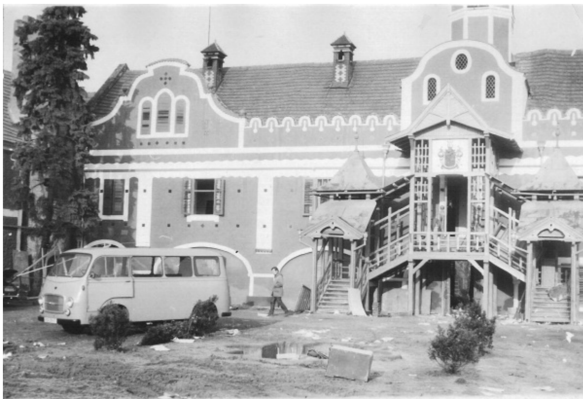
11. Zámek od jihu – po opravě fasády, kolem 1970
