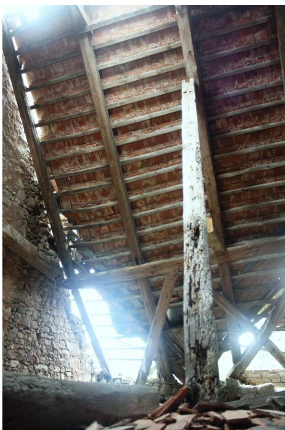
102. Podkroví, východní část, pohled od jihu na krov
