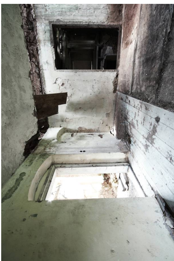
85. Patro, místnost 2.10, pohled od východu
