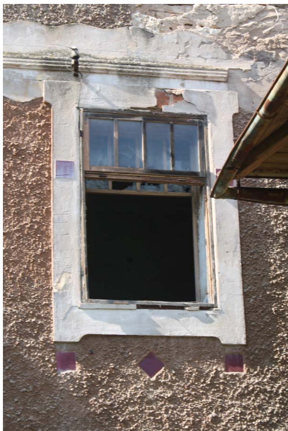
11. Jižní průčelí, detail okna v patře
