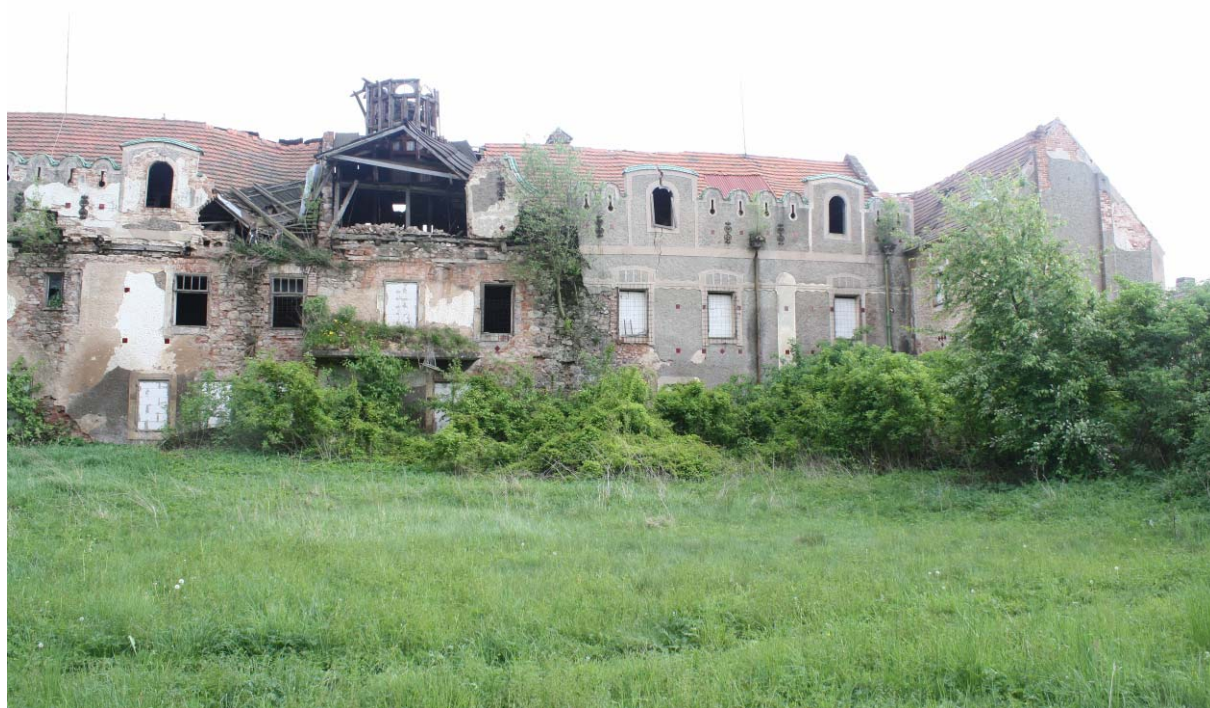
18. Severní průčelí, západní část
