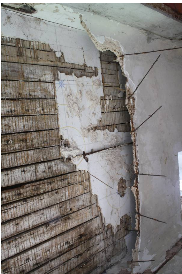
28. Přizemí, místnost 1.01, detail zastropení (Z část)
