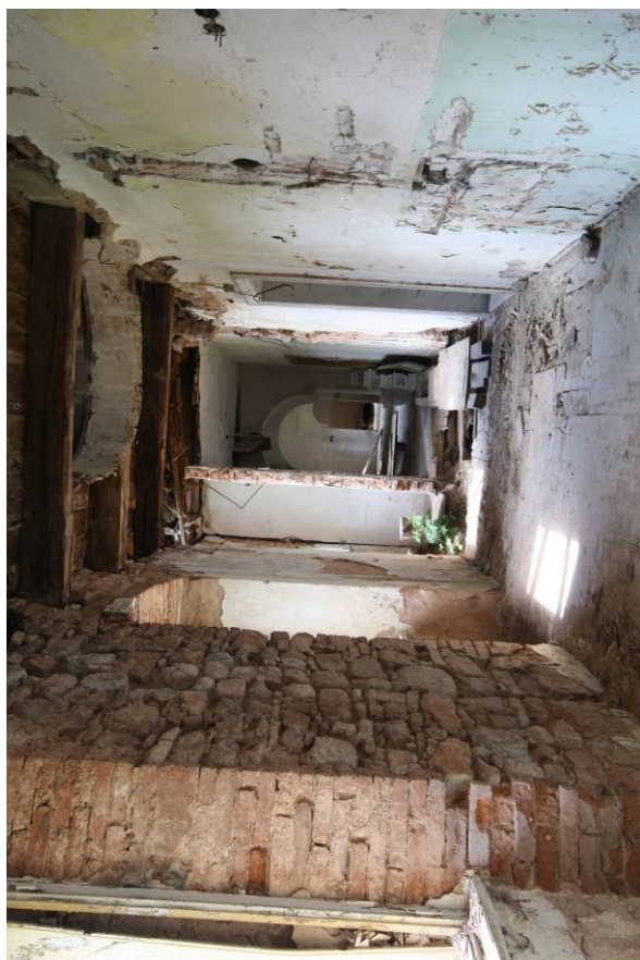
59. Patro, místnost 2.01, průhled od východu
