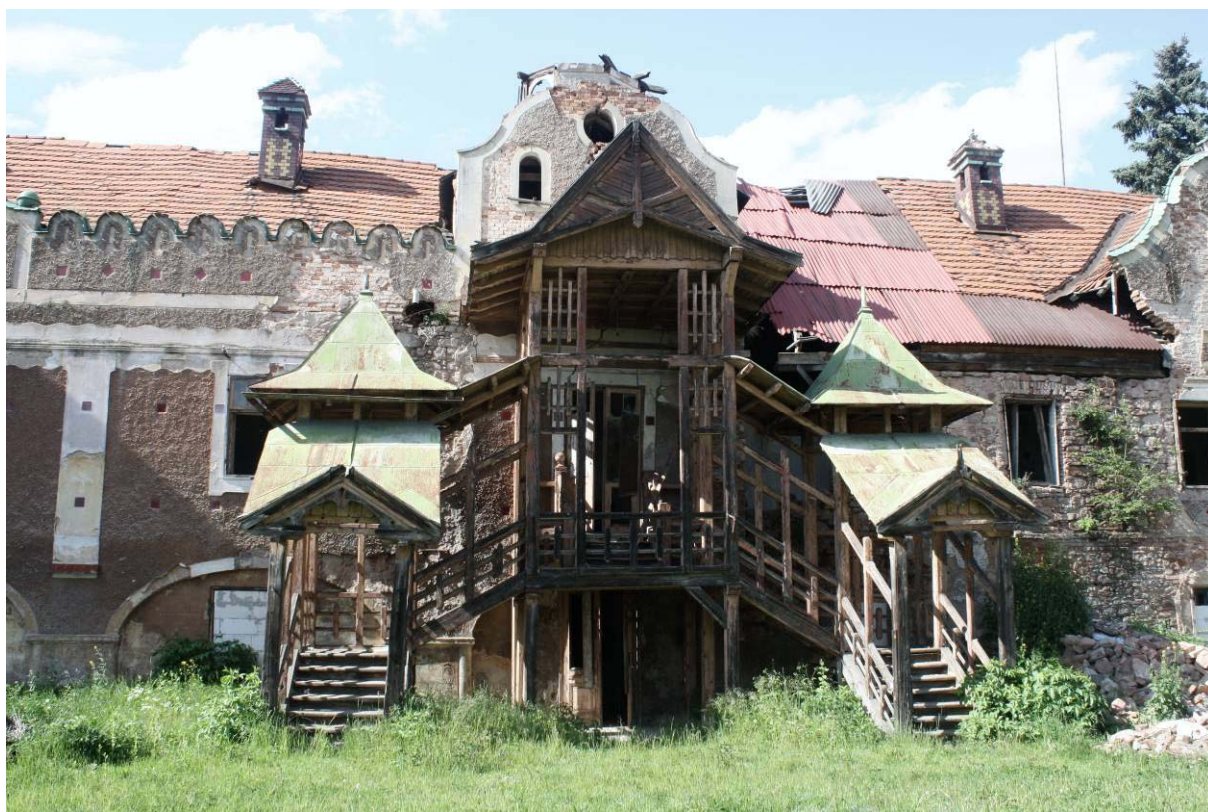
04. Jižní průčelí, středová partie se schodištěm
