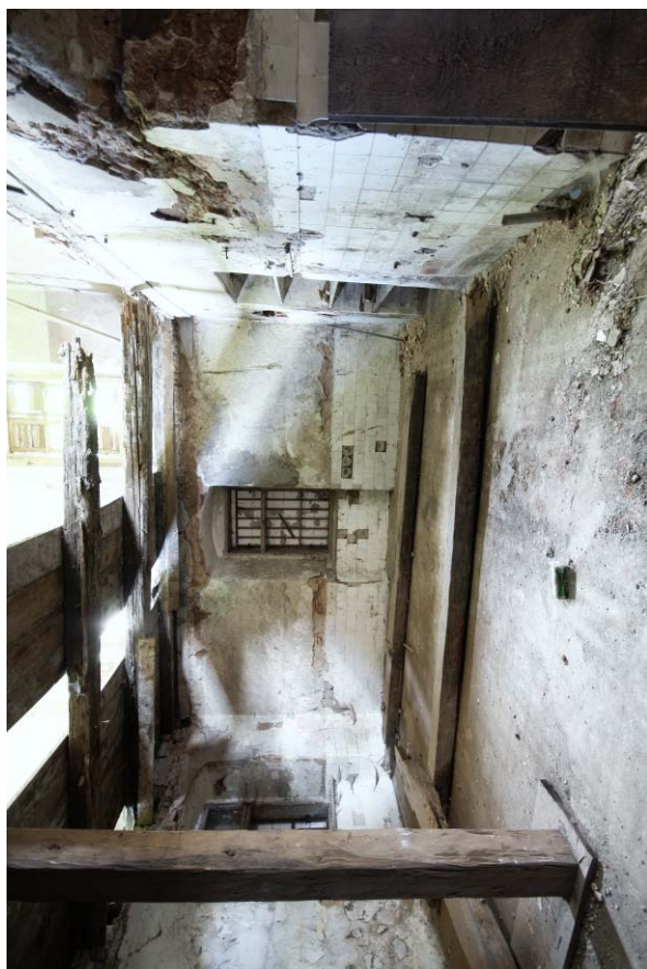
45. Přízemí, místnost 1.08, průhled od západu
