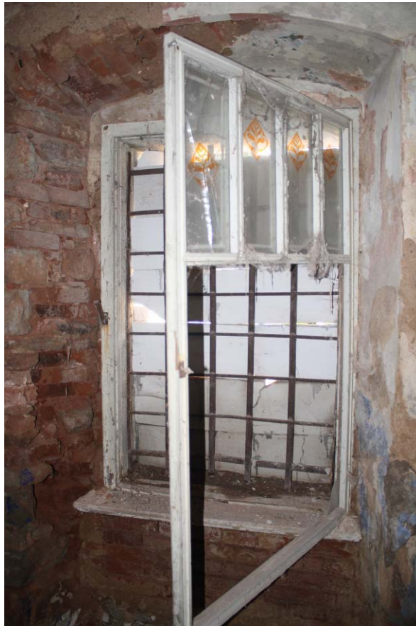
32. Přízemí, místnost 1.03, detail okna v jižní stěně
