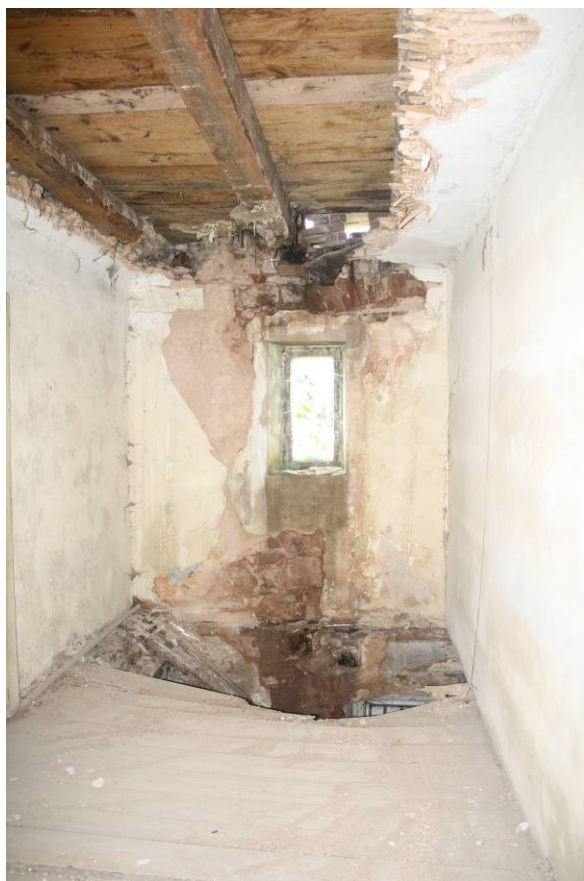
87. Patro, místnost 2.11, průhled od jihu
