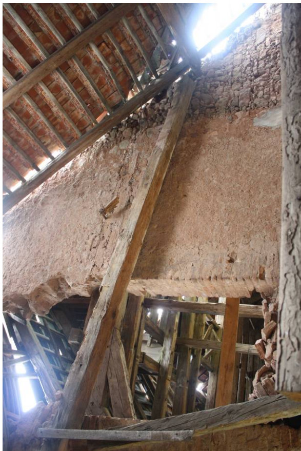
100. Podkroví, východní část, pohled od V na protipožární štít
