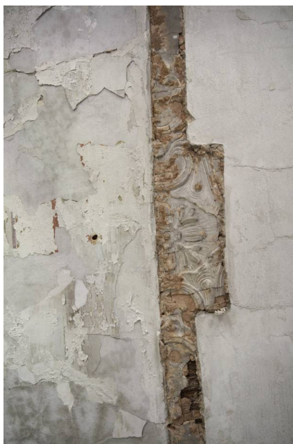
81. Patro, místnost 2.08, detail štukového dekoru stropu
