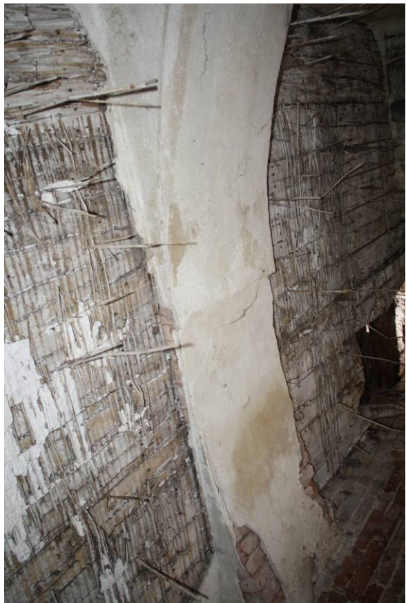
51. Přizemí, místnost 1.09, detail stropu
