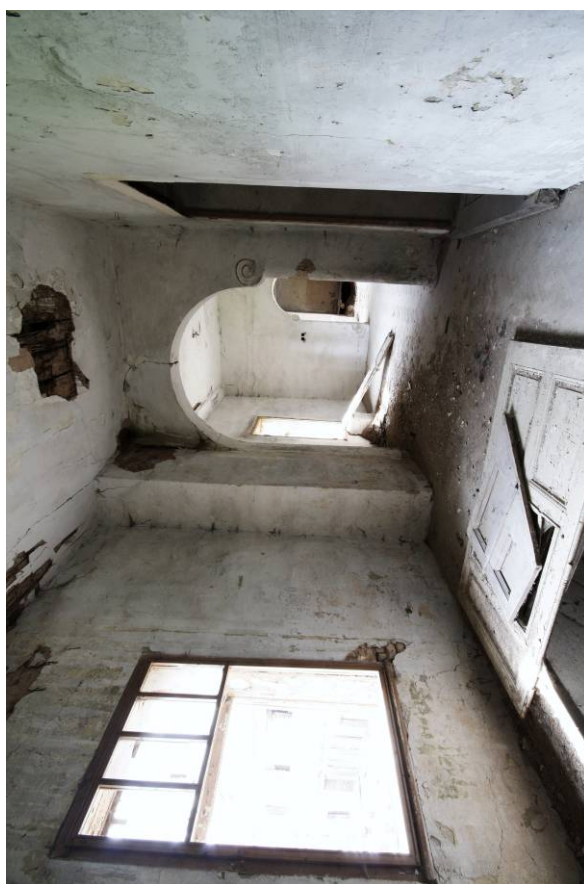
71. patro, místnost 2.04, průhled od východu
