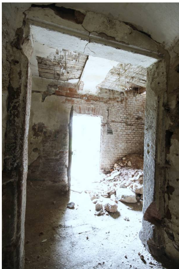
49. Přizemí, místnost 1.09, průhled od severu
