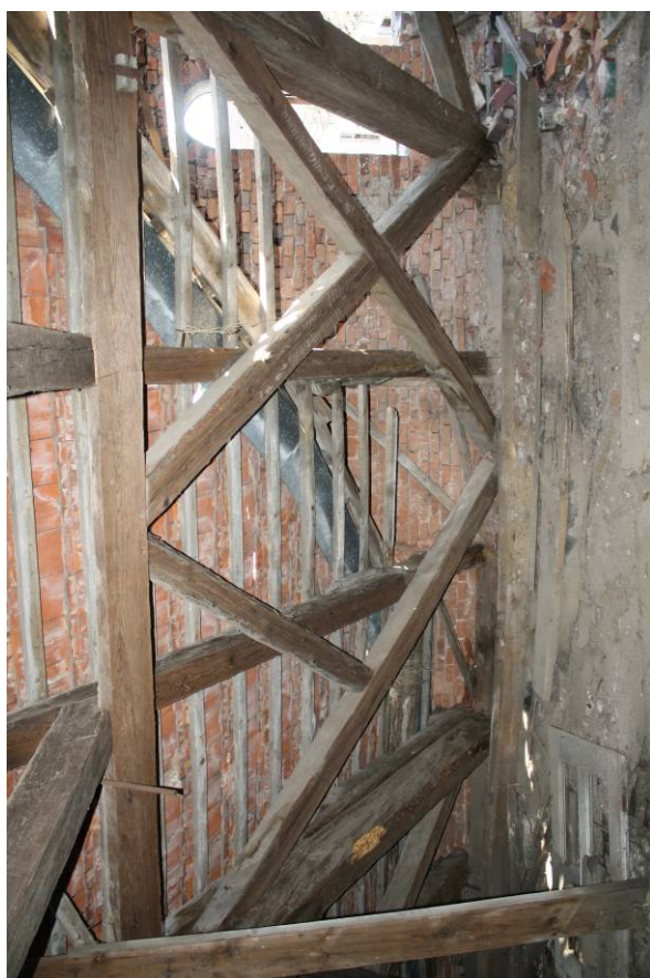
96. Podkroví, západní část, detail podélného zavětrování krovu
